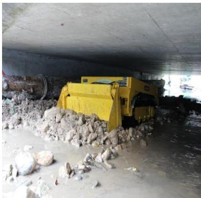
Rimozione della sabbia negli **impianti di trattamento delle acque**.
